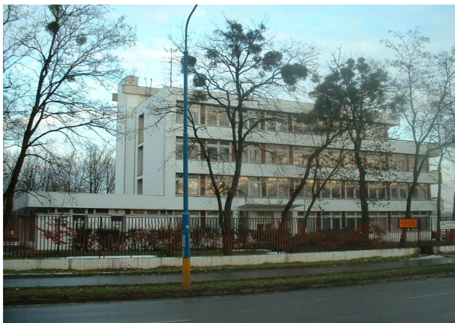
Administratívna budova PSSR, š.p. v Bratislave
