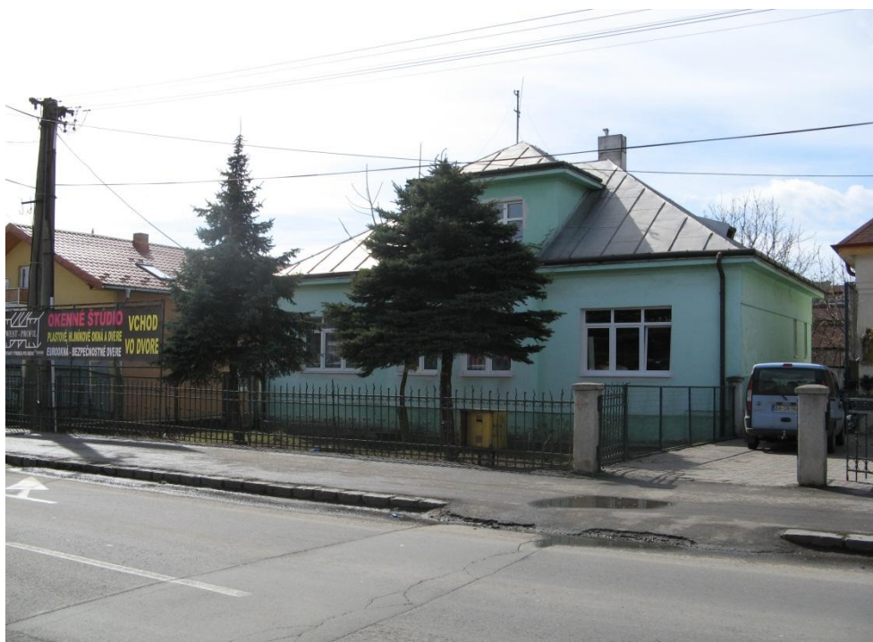
Administratívna budova PSSR, š.p. v Humennom
