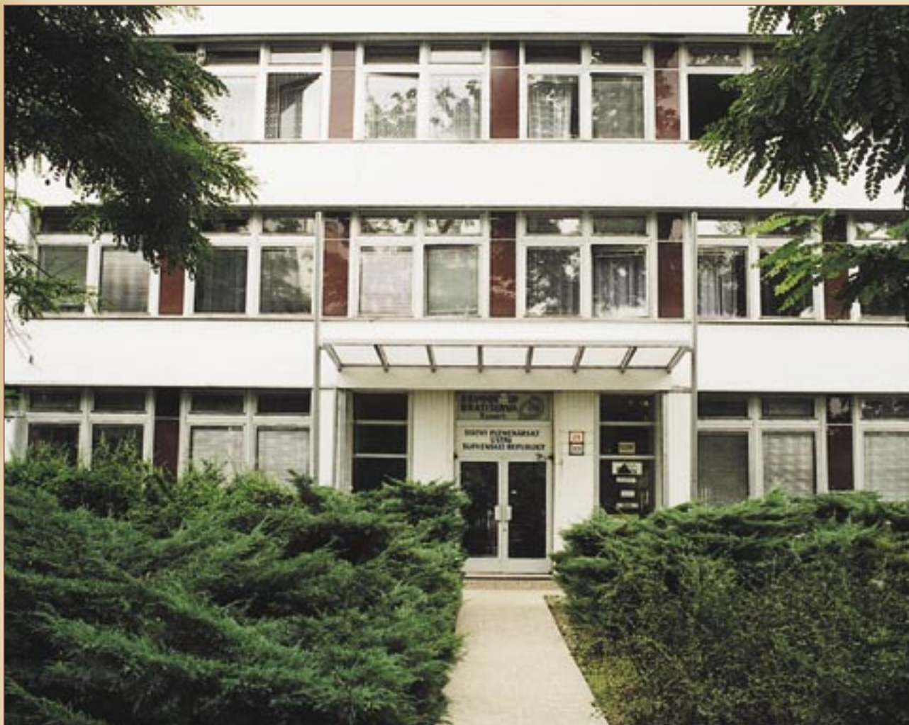
Budova ŠPÚ SR v Bratislave
